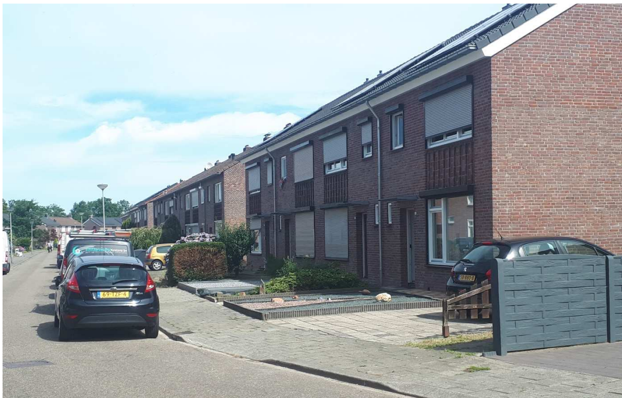
Renovatie woningen Nieuwdorp
