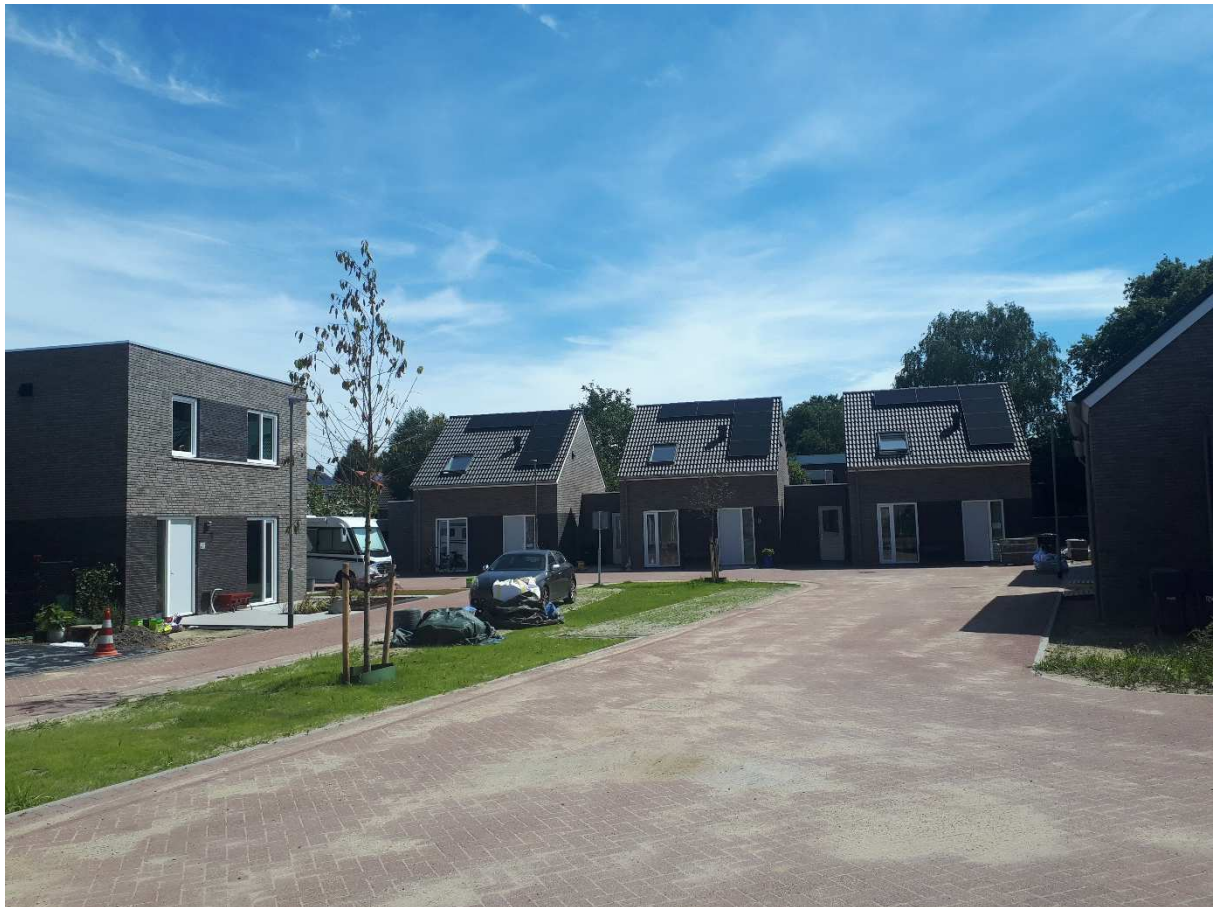
Nieuwbouw Greune Graaf, Elsloo
