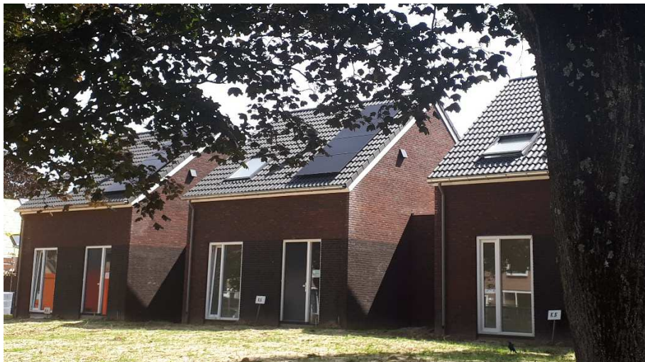
10 woningen Dross. Esserstraat Elsloo
