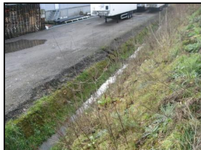
Figuur 4. Smalle sloot en aanliggend talud op onderzoekslocatie.
